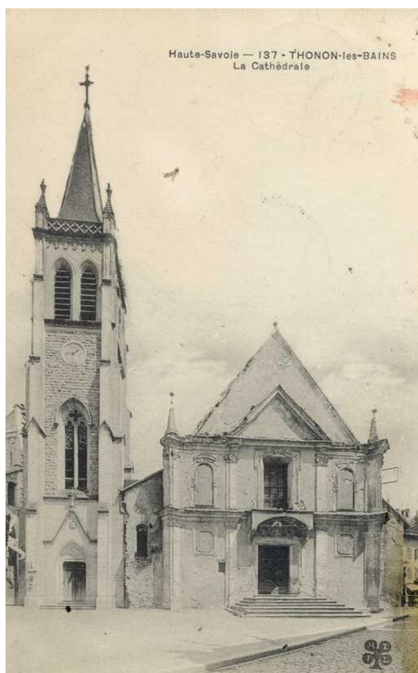
4Fi405 – Eglise Saint-Hippolyte et Basilique Saint François de Sales (1906)
