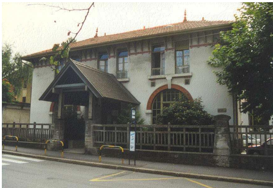
1Fi946 – Ecole Carnot (1997) - construite en 1906 par L. Moynat, démolie en 2003
