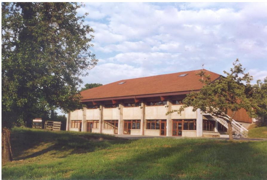
1Fi 2708 – Centre aéré de Marin (SD)
