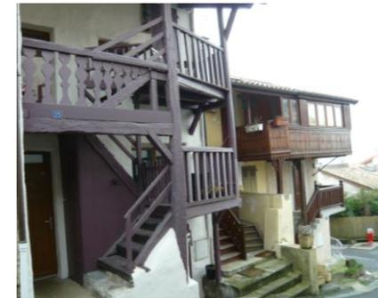
Les menuiseries sont généralement en bois peint, souvent à six carreaux. Les volets sont également en bois peint, à cadre ou à double lambris. Le modèle le plus répandu est à deux vantaux avec le tiers supérieur persienné. Les petites ouvertures ne sont munies que d'un volet à un seul battant, pliant ou non.
