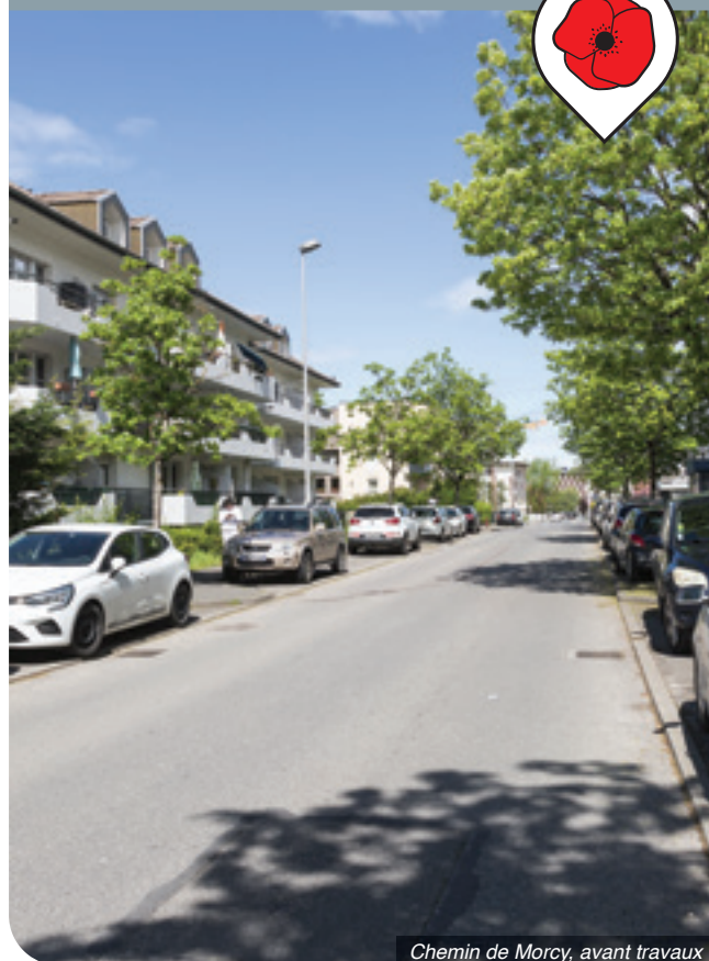
Chemin de Morcy, avant travaux
