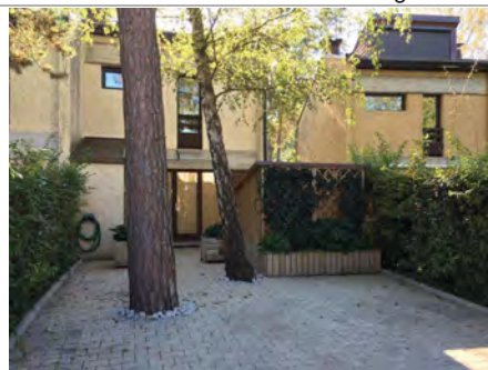
Pavés béton autobloquants Espace entièrement minéralisé : interdit
