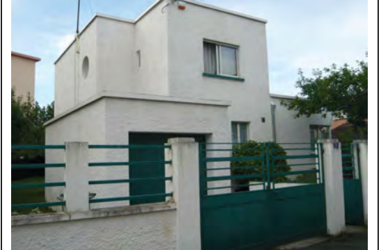
Murets surmontés d'un barreaudage en serrurerie
