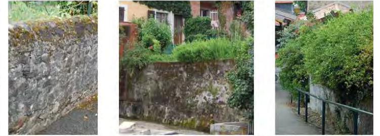
Murs constitués de moellons de pierre locale, liés par des éclats de pierre pour caler et plus ou moins enduits à la chaux.
