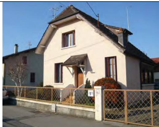
Murs maçonnés surmontés d'une serrurerie à barreaudage vertical
