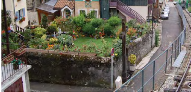
Murs constitués de moellons de pierre locale, liés par des éclats de pierre pour caler et plus ou moins enduits à la chaux.
