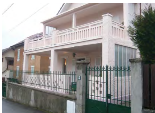
Mur maçonné et barreaudage vertical en serrurerie
