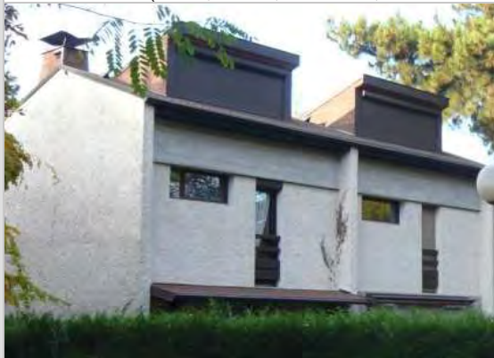
Linteaux en béton brut apparent
