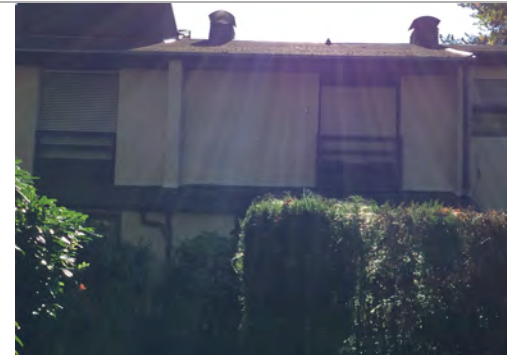
Des volets roulants sont admis à condition d'être de teinte brun foncé, en alu de préférence, et de poser le coffret d'enroulement à l'intérieur du bâti
