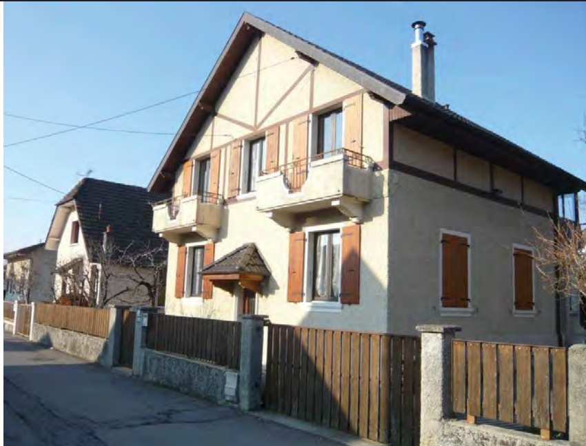
Murs maçonnés surmontés d'une clôture lattis bois
