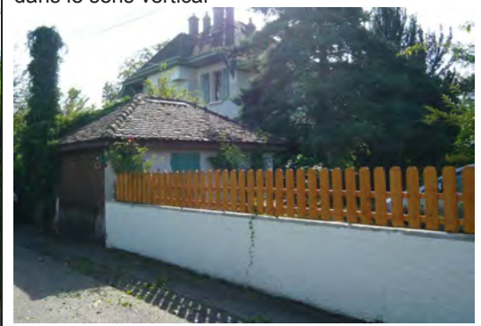
Mur maçonné surmonté d'une clôture de paline de bois arrondie en partie supérieure, posée dans le sens vertical
