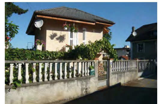
Mur maçonné surmonté d'éléments en serrurerie et doublé de végétal
