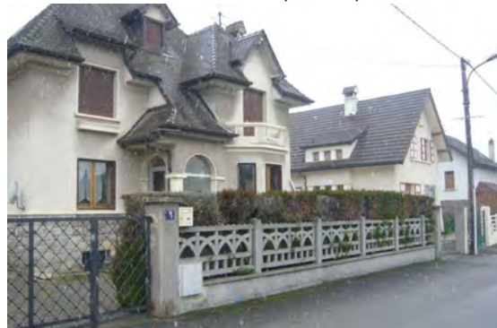
Muret béton et éléments préfabriqués en béton à dominance horizontale
