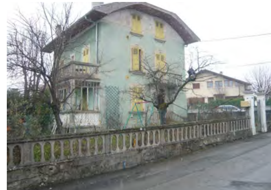
Mur maçonné et lisse béton
