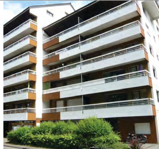
Garde-corps pleins (béton) et lisses métalliques et serrurerie
