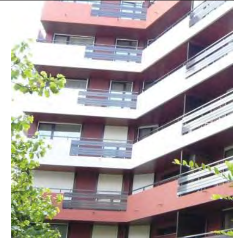
Alternance de garde-corps pleins (béton) et menuisés (ajourés) de teinte foncée
