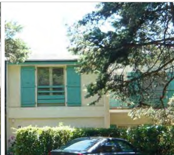
Coloration des menuiseries dans des teintes colorées, atténuation des contrastes, perte d'unité et de cohérence de l'ensemble urbain remarquable : interdit.
