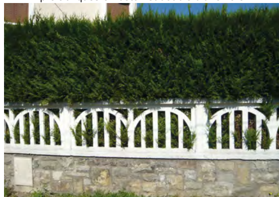
Socle en béton et éléments préfabriqués en béton
