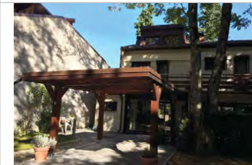
Construction récente conforme au modèle d'origine
