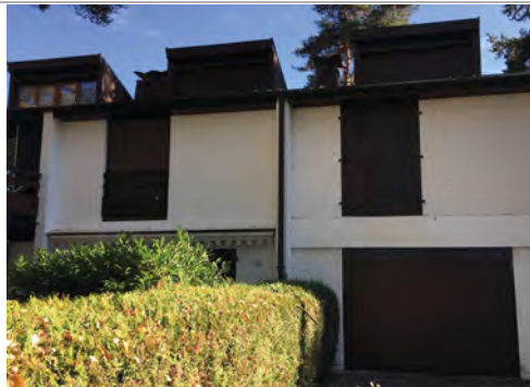
Le remplacement des volets en bois s'effectuera par des modèles similaires, en bois, double lambris, sur écharpe en Z, de teinte brun foncé
