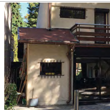
Barreaudage en serrurerie fine sur baie en rez-de-chaussée autorisé : sur baie de petite dimension
