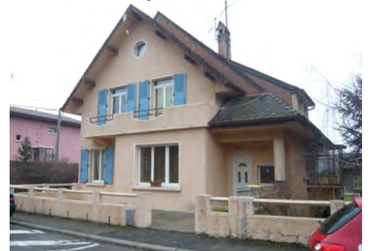
Mur maçonné et balustres en béton
