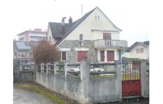
Muret en béton surmonté d'éléments en serrurerie à dessin géométrique et barreaudage vertical
