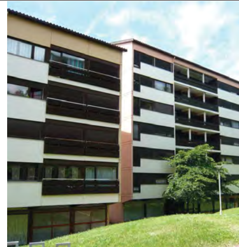
Garde-corps menuisés de teinte brun foncé
